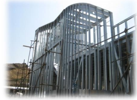
(اجرای سازه LSF به روش بالن معکوس)
